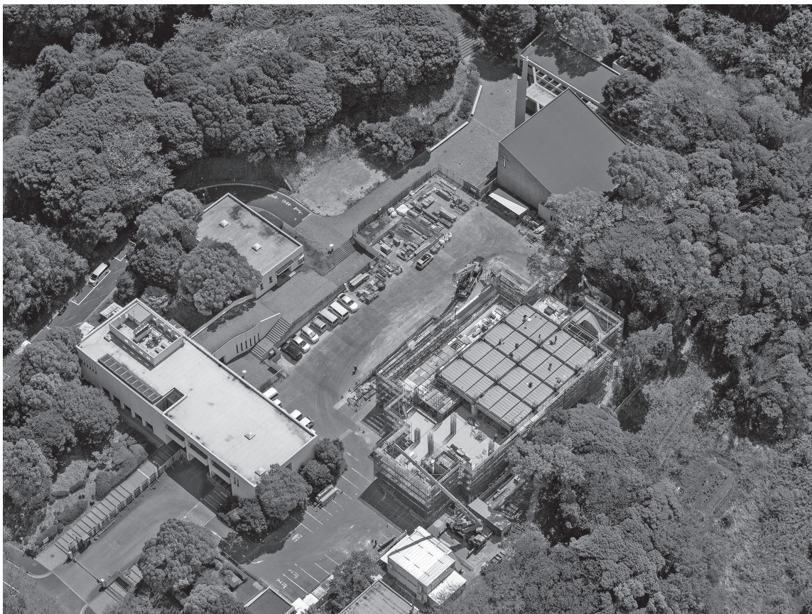
横浜キャンパス 建設中の新校舎
